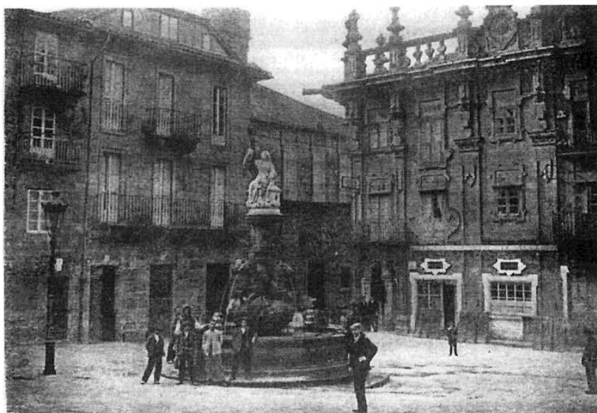
Aspecto que presentaba la Plaza de Platerías antes del derribo de las casas ubicadas en el solar adquirido por el Banco de España. (Foto: Hermógenes Garita).
