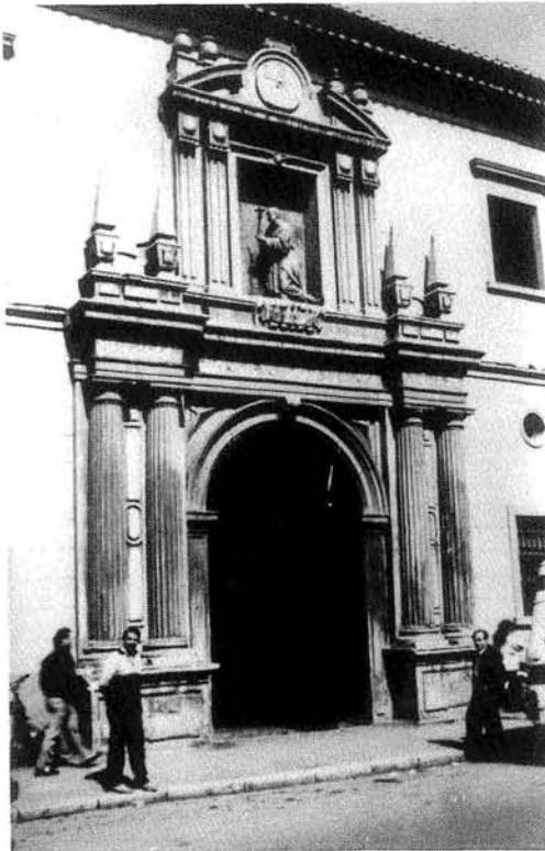
Figura 12.- Portada del Hospital de San Juan de Dios en Granada. Ambrosio de Vico. 1609.
