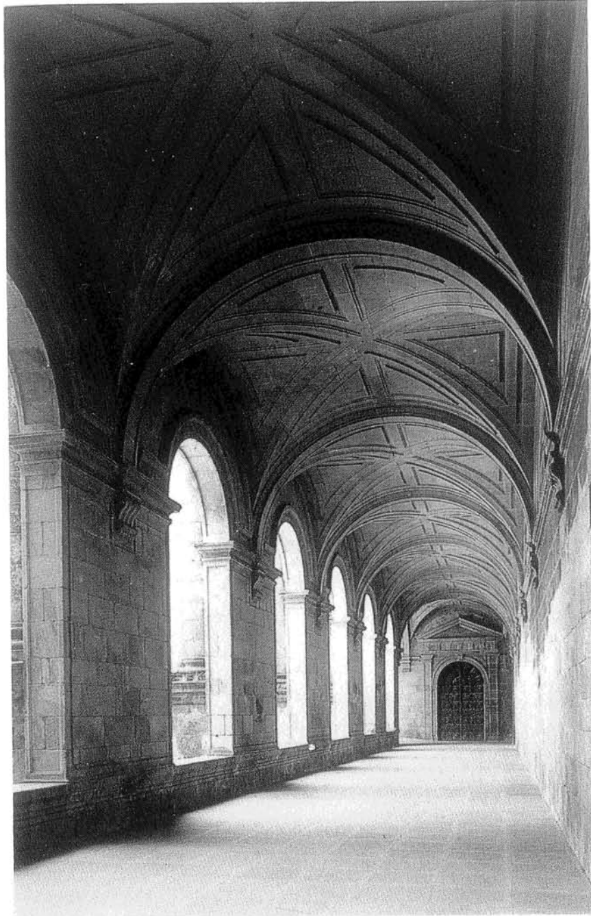
Figura 4.- Galería interior del Claustro Procesional.
