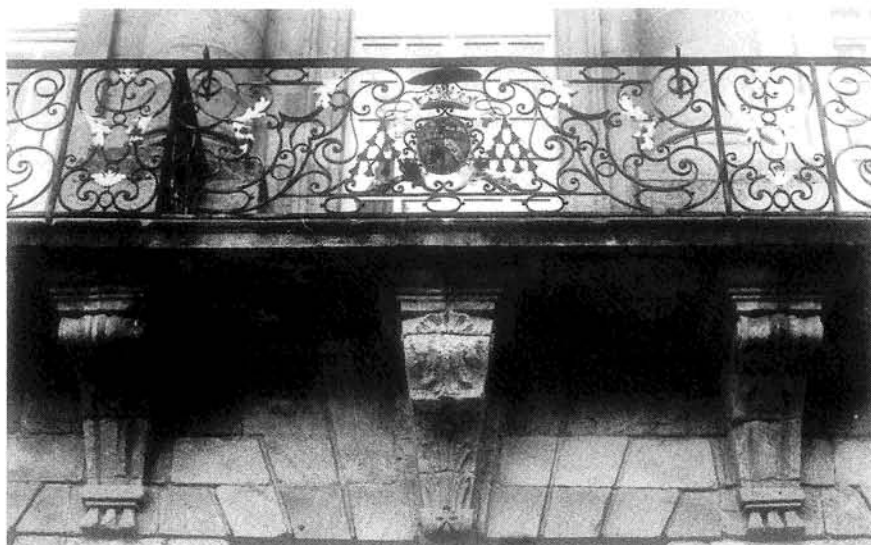
Fig. 16: Detalle de las ménsulas de uno de los balcones del Seminario-Consistorio de Santiago.
