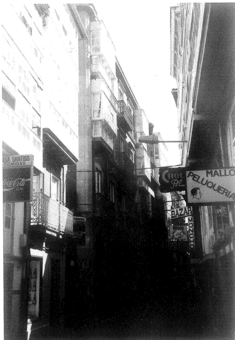
Lámina V: Edificio Simeón. C/ Franja, nºs 20-22. La Coruña.
