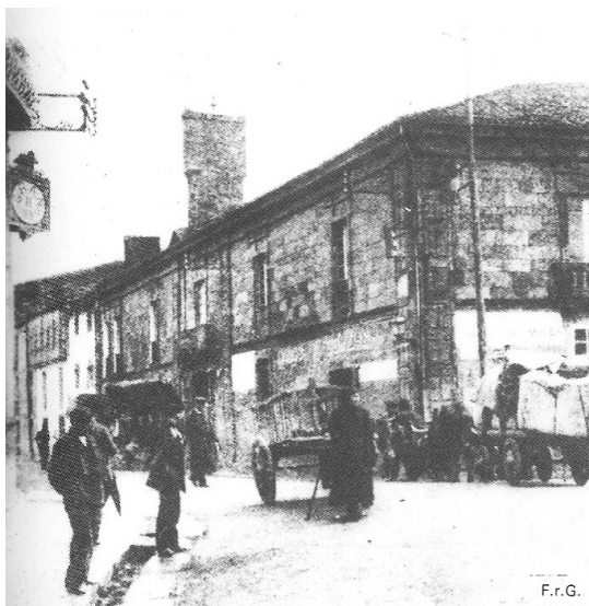
Fig. 2 Casas de la Inquisición de Santiago. Fachada norte
