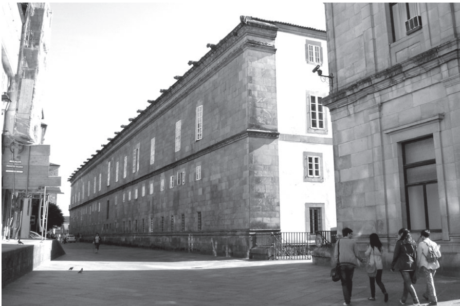
Fig. 11. Fotografía encuentro esquina Noreste (actual). Fotografía propia.
