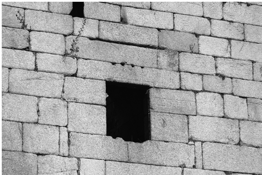
Fig. 6. Ventana en el lienzo sur del recinto interior, sobre la iglesia del patio de armas. Presenta los restos en negativo de un enrejado y la inscripción AVE MARIA en la parte derecha.
