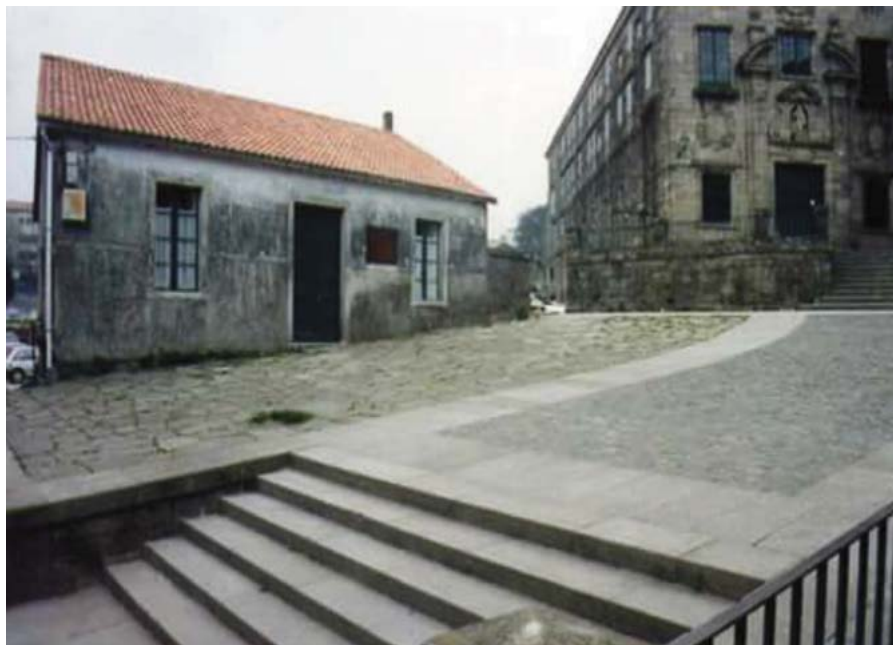
Fig. 2. Edificio donde finalmente se instaló la gota de leche. Fotografía cedida por F. J. Ponte Hernando.
