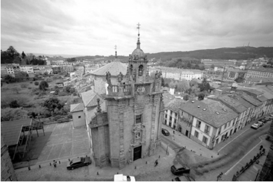
Fig. 4. Estado das rúas da Trindade, Hortas e Carretas antes da actuación. (Imaxe cedida por Cristina Ansede).
