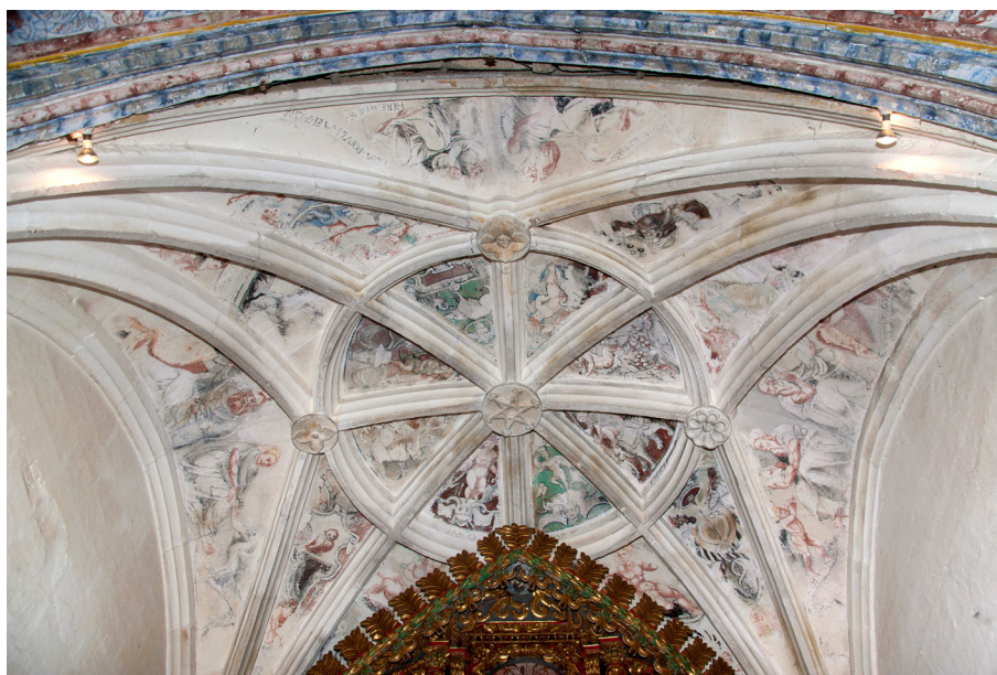
Fig. 8. Bóveda de la capilla mayor de Santa Baia de Banga. Fotografía de Xulio Gil.
