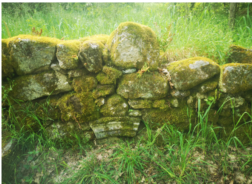
Fig. 1. Muro en el camino que lleva a la iglesia de Santa Baia de Banga (primavera del 2024). Fotografía del autor.
