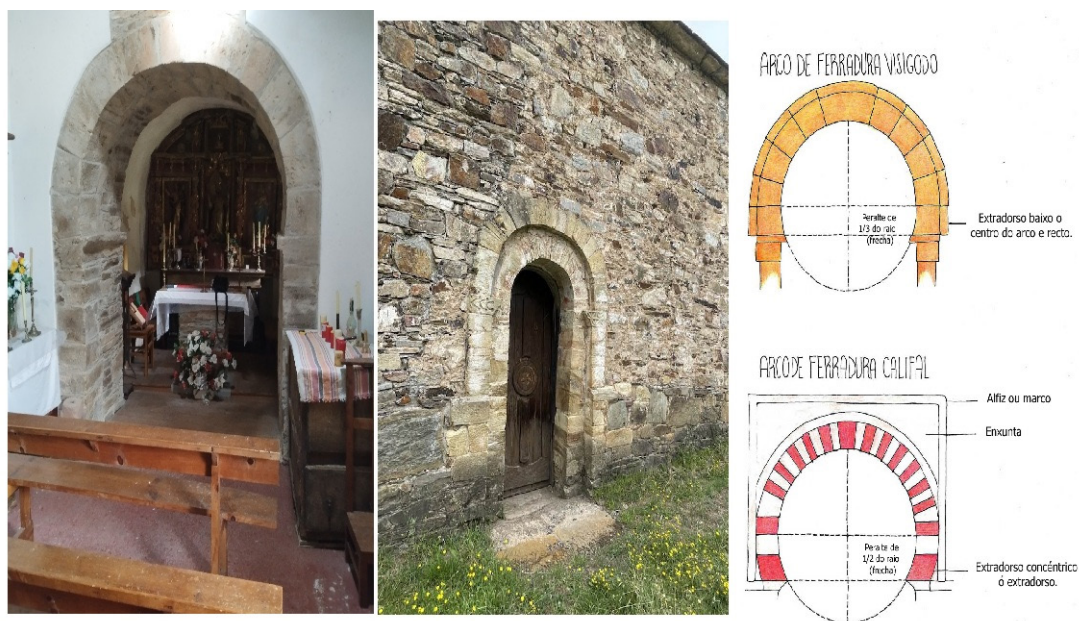
Figura 5. Arco triunfal de Liber, arco lateral sur das Nogais (fotografías do autor) e esquema de arco de ferradura “visigótico” e califal, de Proxecto Ende, https://recursos.edu.xunta.gal
