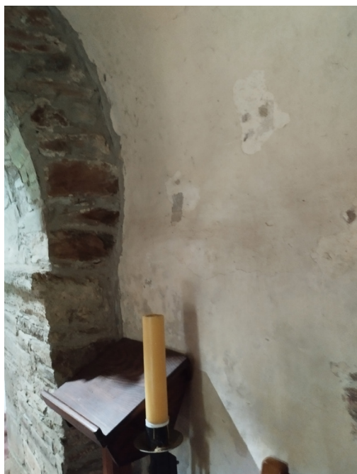
Figura 6. Liber. Arranque da bóveda de ferradura (fotografía do autor).
